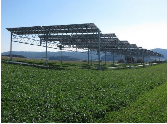
Abbildung 1: Testanlage einer hoch-aufgeständerten Agri-PV-Anlage auf einem Ackerfeld. [4]
