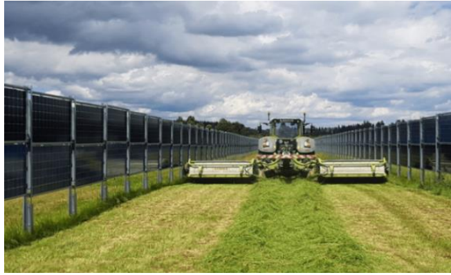
Abbildung 2: Bifaziales Agri-PV-System mit landwirtschaftlicher Nutzung zwischen vertikal aufgeständerten Modulreihen [7]
