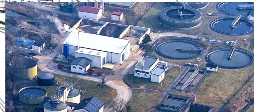
Energiezentrale auf der Zentralkläranlage
