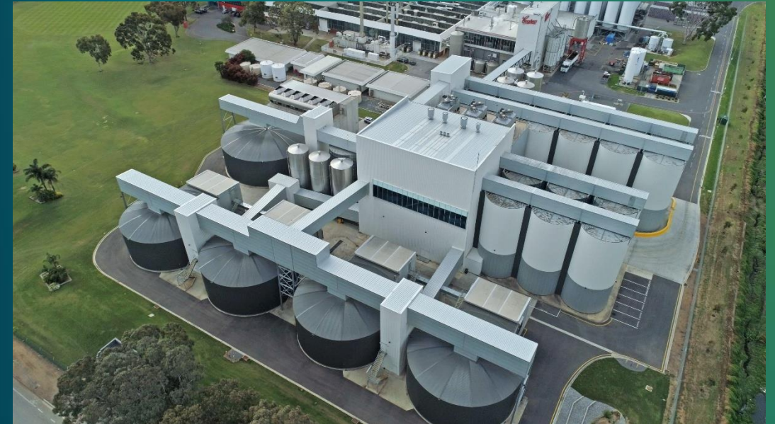
Mälzereianlage der Brauerei Coopers in Australien
